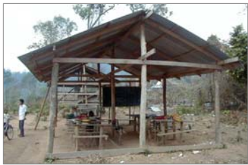
壁も床もない校舎
