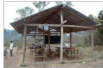
壁も床もない校舎
